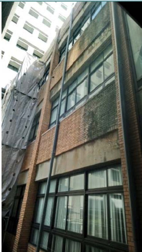
圖書館外牆-Before (近照更嚇人)
