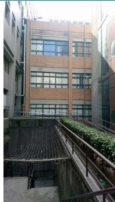
圖書館外牆-After (改頭換面)
